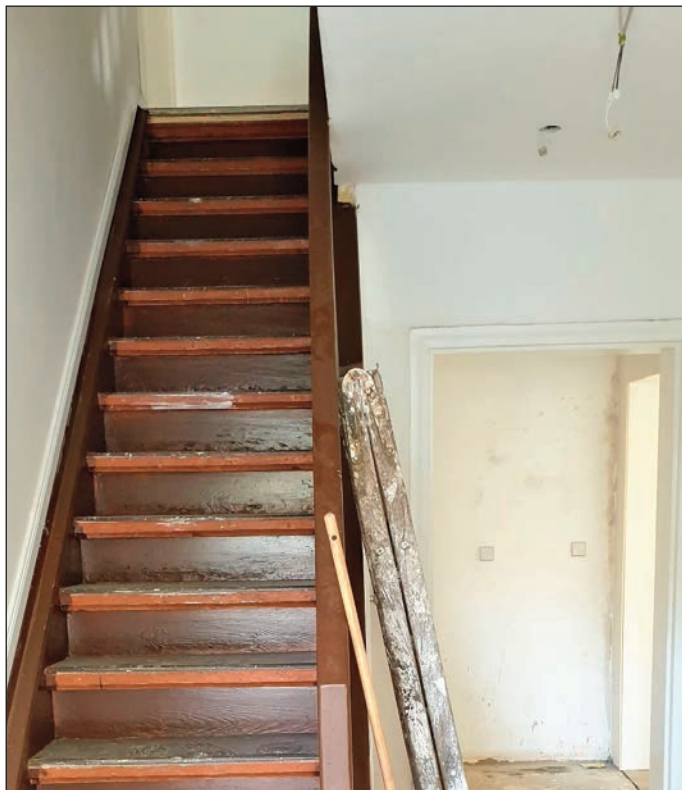
Die Treppe während der Renovierung.
